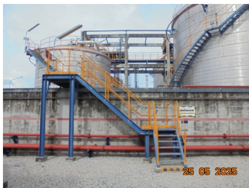
รูปที่ 3.2-56 คั่นคอนกรีตล้อมรอบถังเก็บกัก
