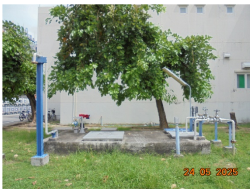
รูปที่ 3.2-16 ถังบำบัดน้ำเสียสำเร็จรูป (Septic Tank)
