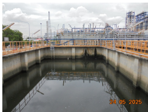
รูปที่ 3.2-17 บ่อพักน้ำทิ้ง (Final Polishing Tank)
