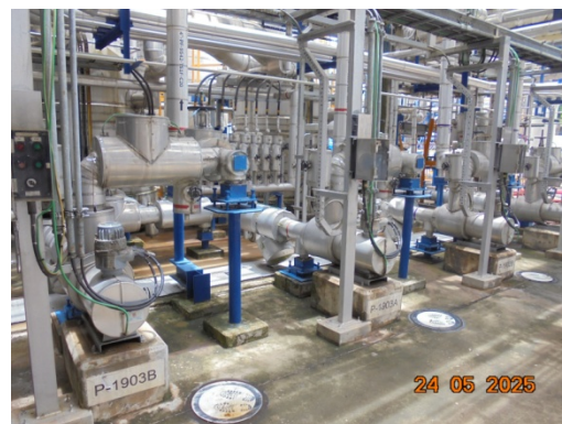
รูปที่ 3.2-8 เครื่องสูบน้ำสำรอง
