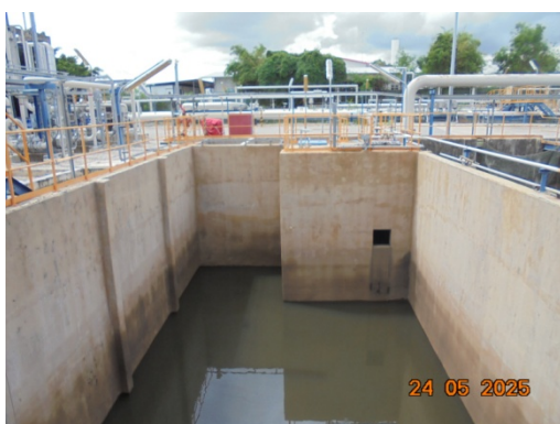
รูปที่ 3.2-18 บ่อรองรับน้ำฝนปนเปื้อน
