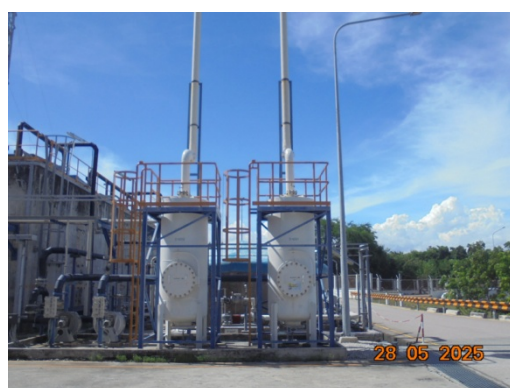
รูปที่ 3.2-5 ปล่องระบบดูดซับไอระเหย สารอินทรีย์ด้วยถ่านกัมมันต์จากระบบบำบัดน้ำเสีย (D-9201 และ D-9202)
