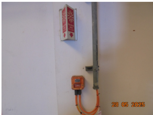
รูปที่ 3.2-40 ระบบเตือนภัย และระบบป้องกันและระงับอัคคีภัย ภายในอาคารพักของเสียของโครงการ โรงงานผลิตสารบิสฟีนอล เอ
