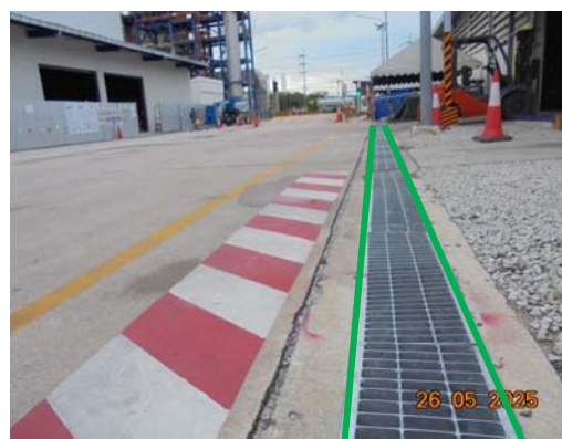
รูปที่ 3.1-9 วางระบายน้ำฝนบริเวณพื้นที่ก่อสร้าง
