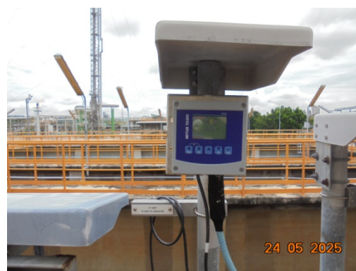
รูปที่ 3.2-19 ระบบตรวจวัดค่า pH แบบอัตโนมัติ
