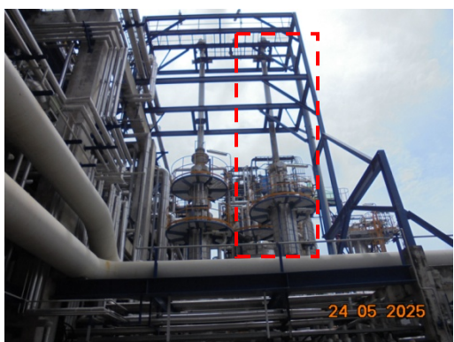
รูปที่ 3.2-2 ระบบ Phenol Scrubber (D-1903)
