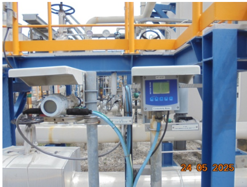
รูปที่ 3.2-20 ระบบตรวจวัดค่า Conductivity แบบอัตโนมัติ
