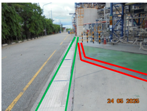
รูปที่ 3.2-24 ระบบรวบรวมน้ำเสียแยกจากระบบ ระบายน้ำฝนอย่างชัดเจน
