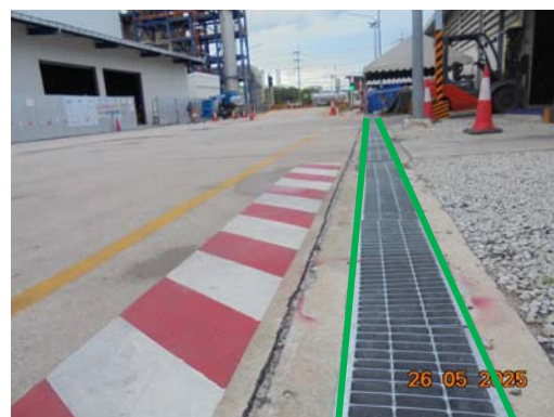
รูปที่ 3.2-25 รางระบายน้ำฝน ของโครงการ
